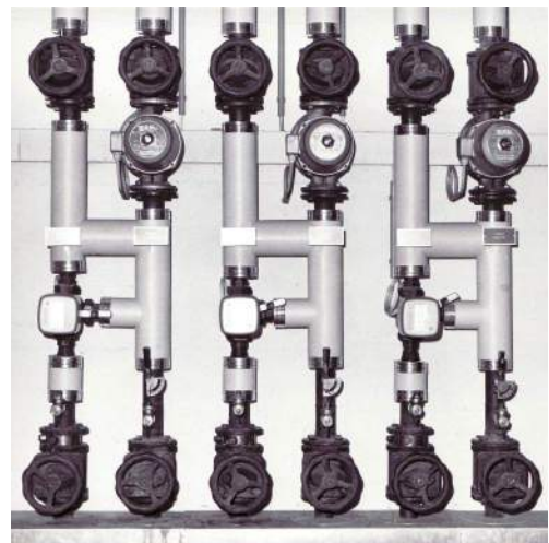
FAQ 24 Abbildung 2: Einspritzverteiler mit Dreiweghähnen
